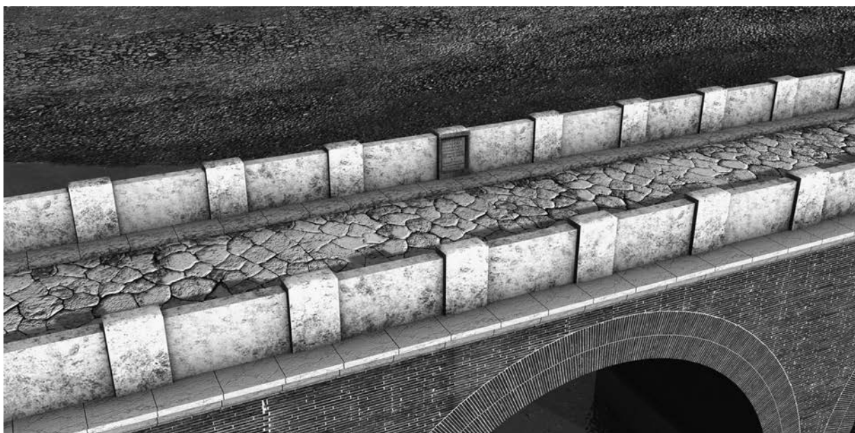
Fig. 12. Ricostruzione virtuale di un ponte della via Traiana con posizione di una lastra sul parapetto.
